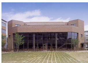
「知の棟」図書館
