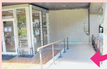
第1学生ホール南側スロープ 本館1階
